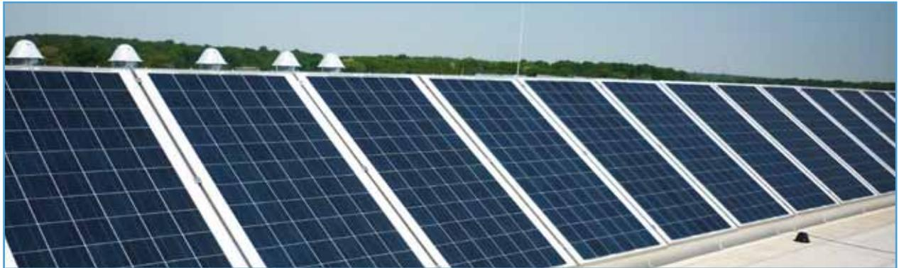
Un projet industriel avec une importante contrainte d'intégration architecturale. Ce bâtiment de 35.000m<sup>2</sup> a été construit dans le respect de la certification américaine LEED®. Modules sur-mesure en 72 cellules avec une puissance de 266Wc par module, spécialement conçus pour une adaptation parfaite sur une structure de sheds en toiture.
