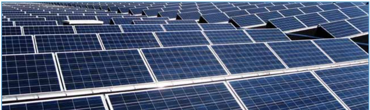
Projet industriel qui a la particularité d'avoir été réalisé avec des composants et des opérateurs situés dans un rayon de 100km. Modules standards installés sur une toiture plate avec le système SIROCCO de HB SOLAR qui a permis un gain de 70% de charge statique grâce au système d'aspiration et de dépression. Système certifié TÜV.
