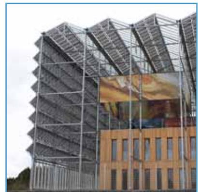
La verrière photovoltaïque de l'Euro Space Center visible depuis l'autoroute E411, entre Bruxelles et Luxembourg à Libin, est composée de plus de 3400 modules Issol semi-transparents. L'installation, d'une puissance de 300 kWc, permet de fournir l'électricité nécessaire aux entreprises présentes sur le site. Ce projet se distingue par son caractère architectural. Il démontre la capacité d'Issol à s'adapter à des contraintes esthétiques et à faire de la technologie un nouvel outil d'intégration.
