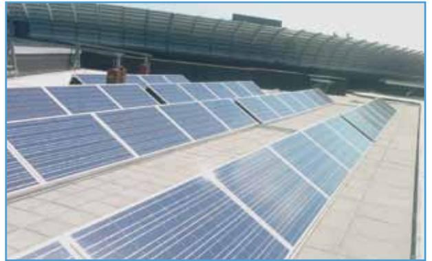
Installation sur la toiture plate des bâtiments AXA près de la Commission Européenne à Bruxelles. Fixations avec le système SIROCCO de HB SOLAR qui a permis un gain de 70% de charge statique grâce au système d'aspiration et de dépression. Système certifié TÜV.
